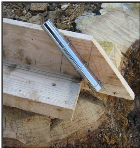
Au temps de passage (à quelques secondes près !), tracer une méridienne lorsque l'ombre du fil incliné couvre celle du fil à plomb. Il faut marquer deux ou trois points et tracer une ligne. D'un coup de tronçonneuse, creuser la méridienne de 5 cm environ. Nous obtenons ainsi la « Méridienne verte de la Besse » !
